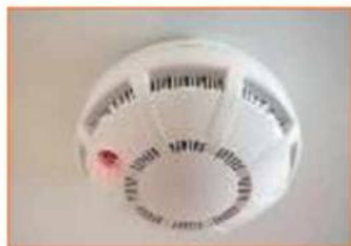
Рис. 4.7. Блок датчиков пожарной сигнализации
