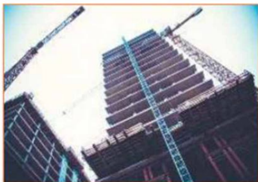
Рис. 7.1. Монолитное строительство с применением химического фрезерования
